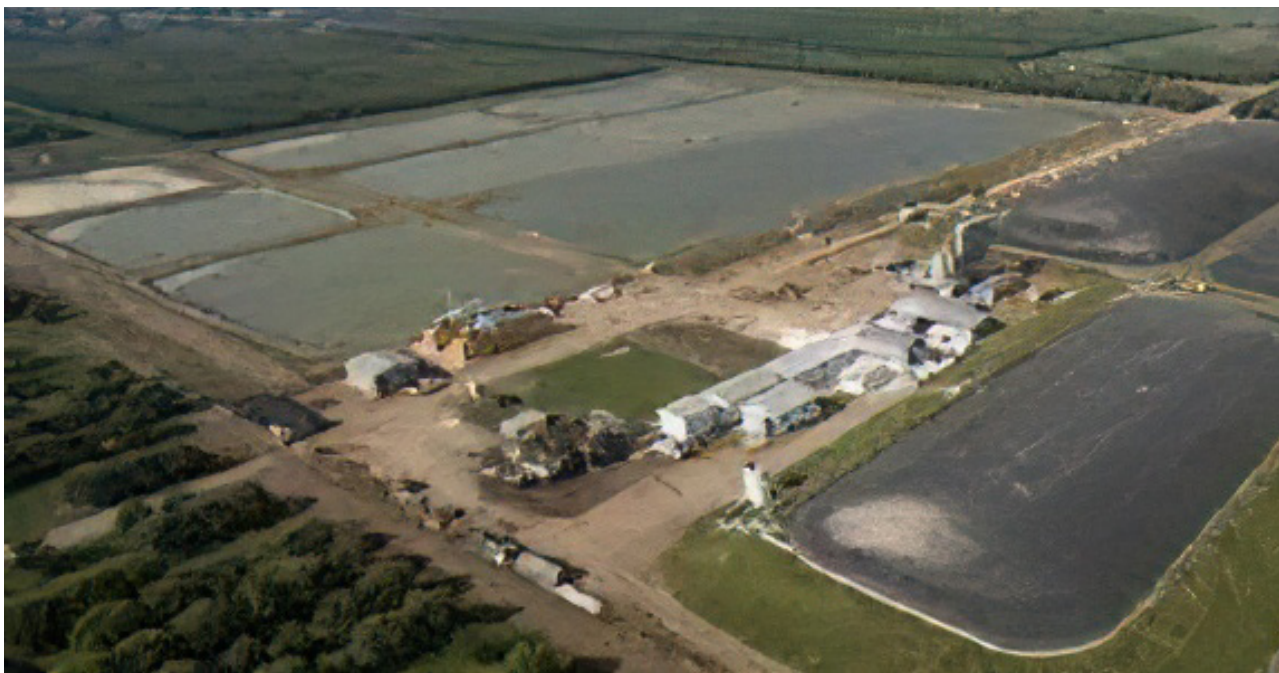
Figura 17. Planta de tratamiento de efluentes, generación de biogás y electricidad. Citrusvil.
