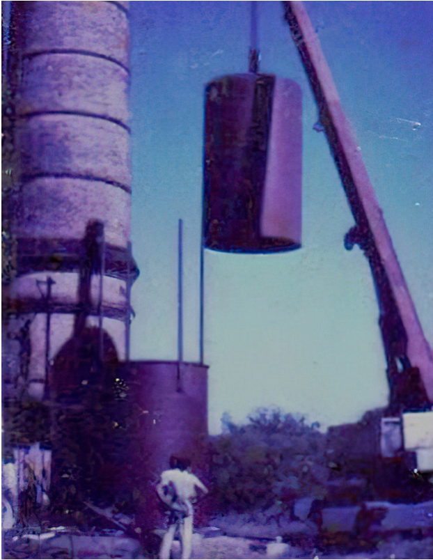
Figura 29. Construcción biorreactor PROIMI. Santa Lucía - 1984.
