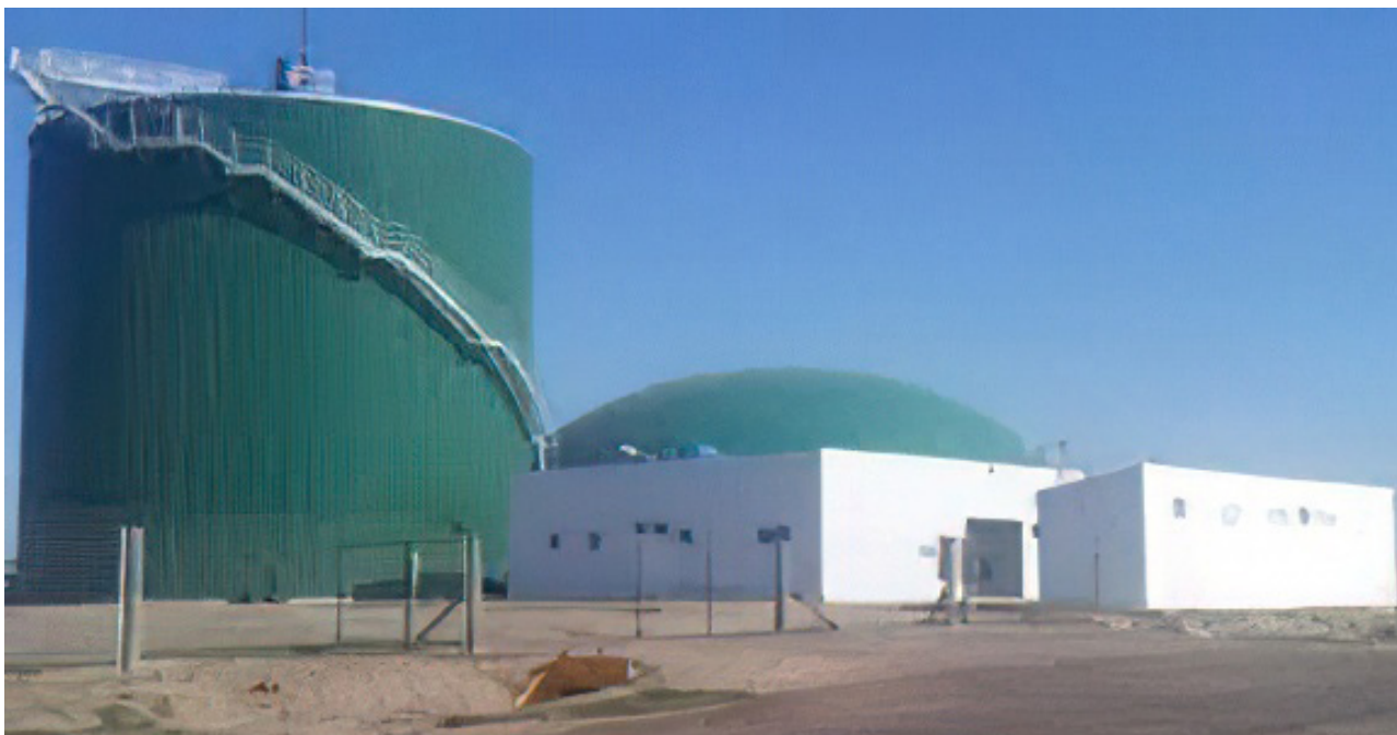
Figura 16. Planta productora de biogás y energía térmica de Bioeléctrica, Río Cuarto.
