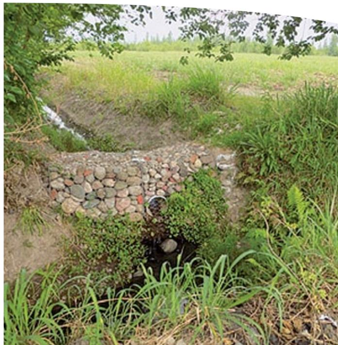
Descarga de canal parcelario en canal colector
