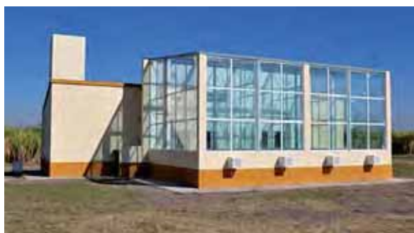
Figura 1. Vista posterior del edificio de Cuarentena de caña de azúcar, emplazado dentro del predio de la EEAOC.
