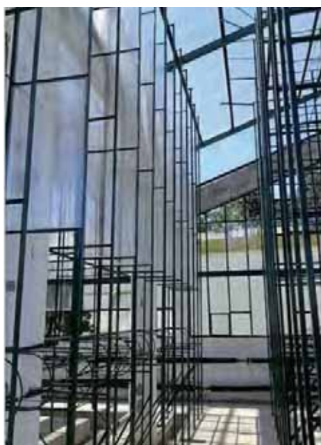
Figura 3. Vista interior de los nuevos cubículos.
