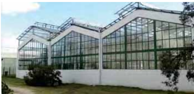
Figura 2. Vista de la ampliación del ala oeste del invernadero de cruzamientos con elevación del techo (ala izquierda) y de los dos módulos derechos refaccionados (invernaderos originales).
