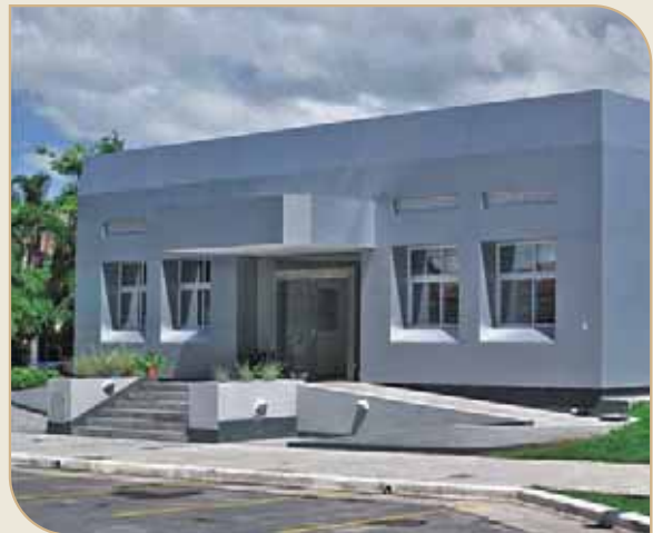
Vista de la fachada del Edificio de Sanidad Vegetal y Suelos y Nutrición Vegetal.
