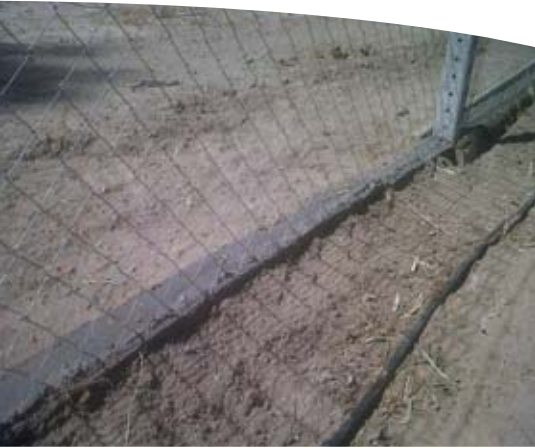
Figura 6. Zócalo de cemento perimetral. Amaicha del Valle. 2014.
