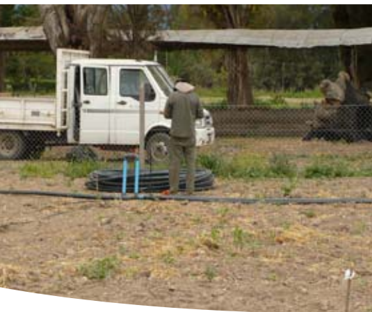
Figura 2. Cabezal e instalación de mangueras de riego. Benjamín Paz. 2012.
